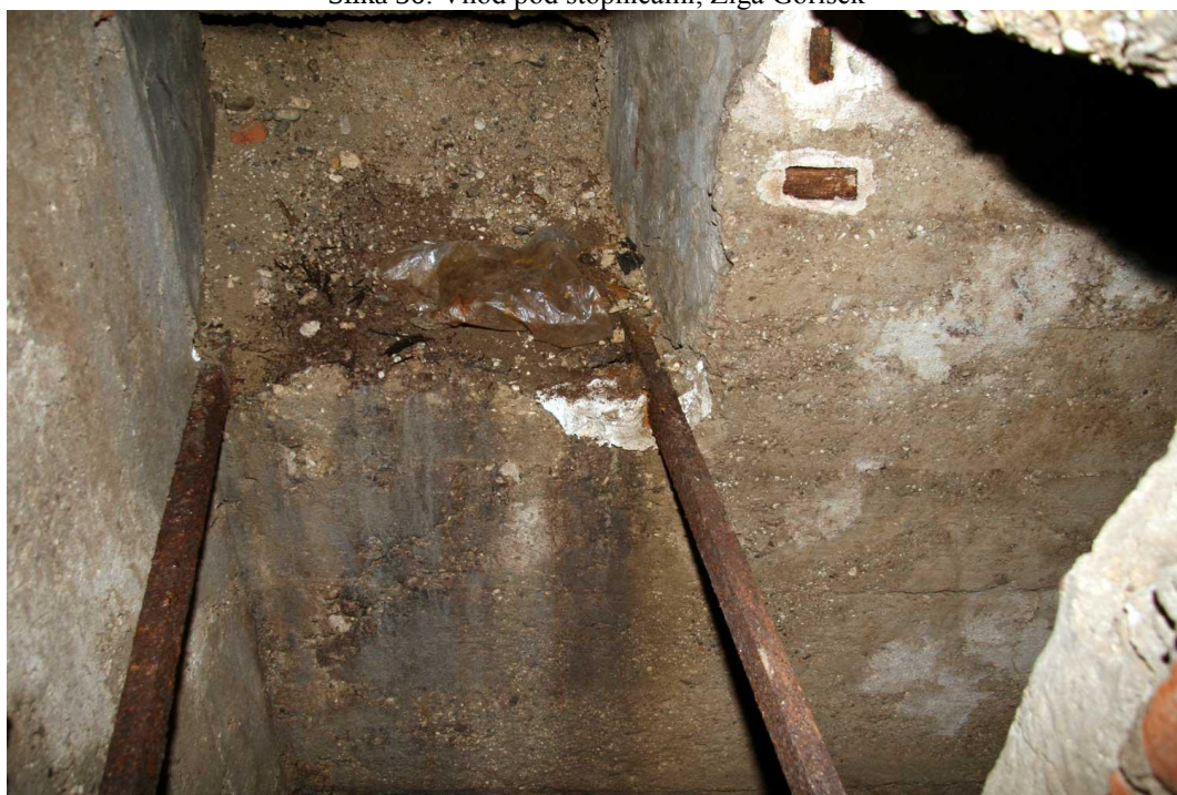
Slika 37: Tračnice, po katerih se je vhod umaknil v za to prirejen prostor, Žiga Gorišek
