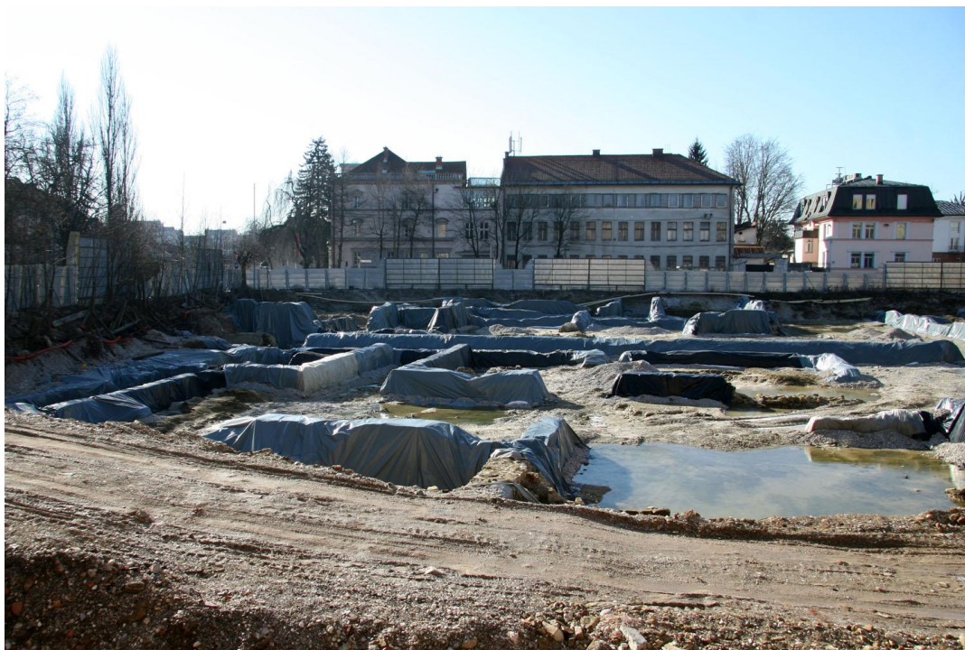
Slika 28: Gradbišče novega NUK-a, Žiga Gorišek
