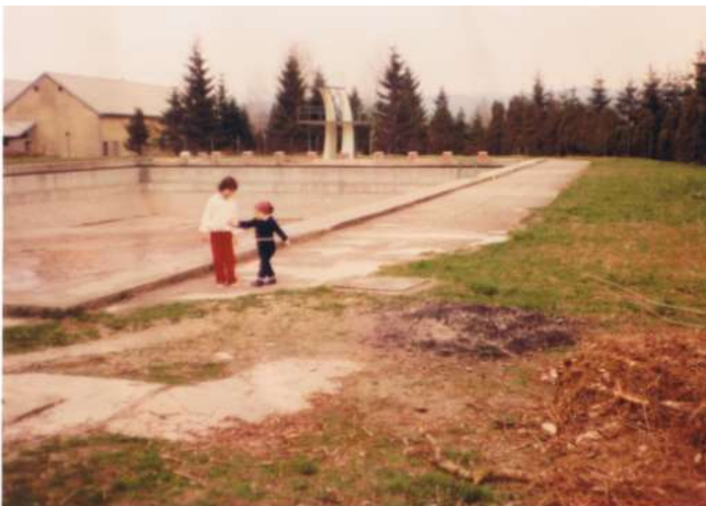
Slika 13: Bazen na začetku osemdesetih, ko je v poletnem času še neuradno deloval. Arhiv: Janez Ličan
